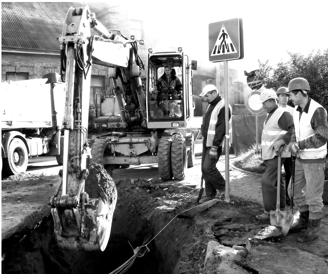
Projekta “Ūdensvada un kanalizācijas tīklu paplašināšana un rekonstrukcija” laikā darbi tiek veikti arī Helēnas un Jāņkalna ielas krustojumā
